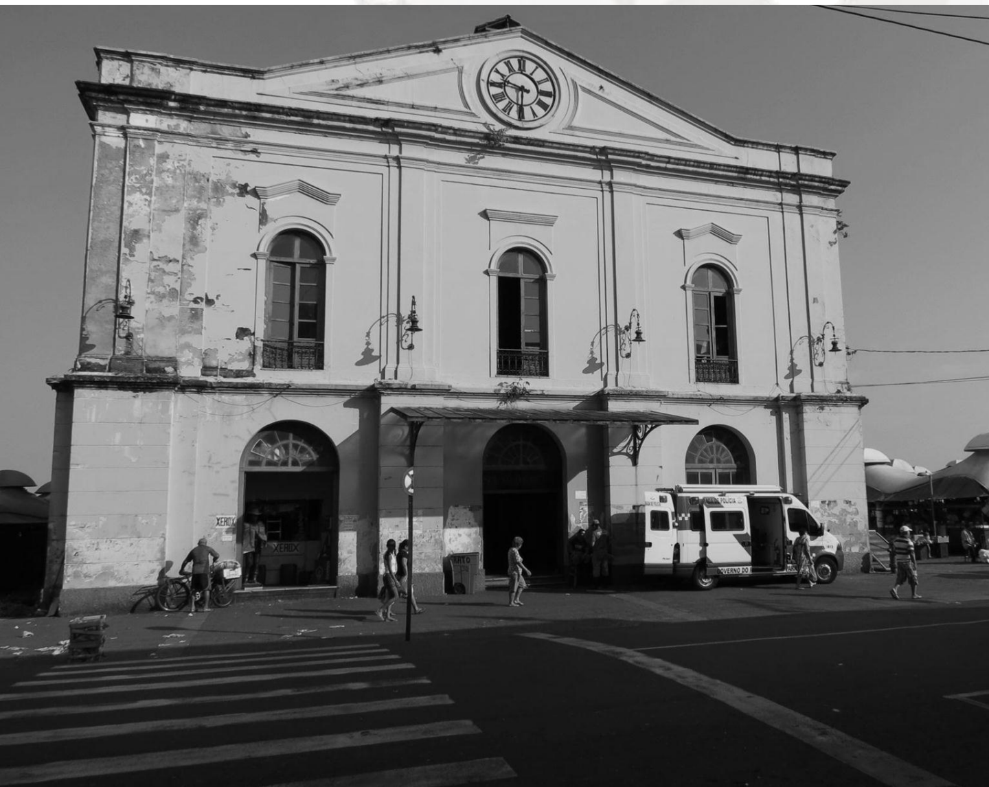
Solar da Beira - Complexo Arquitetônico do Ver-O-Peso – Belém - PA
